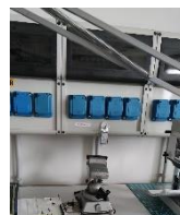
Ambientale 8 Lato corridoio
