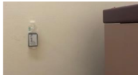
Ambientale 1 Lato corridoio
