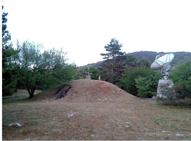
Figura 3 - Veduta esterna del Bunker adiacente alla parabola 3m
