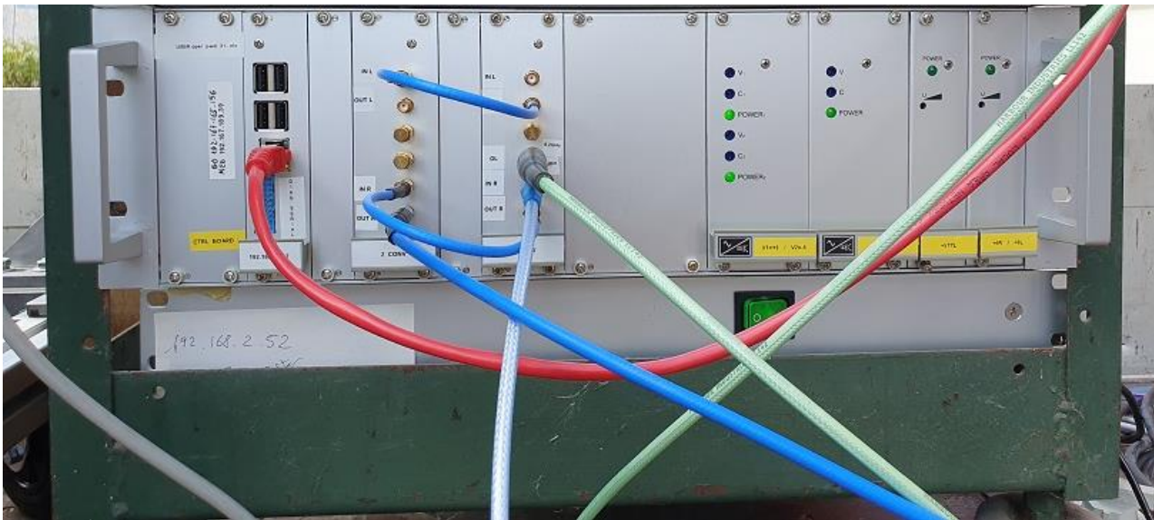
Fig. 6.1 Il cestello che contiene le conversioni di frequenza. Nella parte sottostante sono collocate le ventole di raffreddamento
