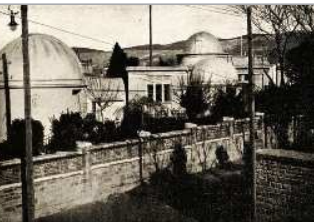
Padiglioni d'osservazione dell'Osservatorio triestino, 1933 Domes of the Trieste Observatory, 1933
