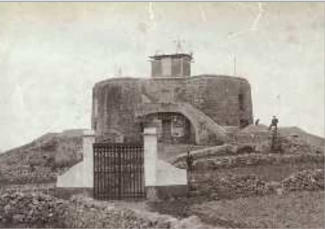
La Stazione Astronomica di Carloforte, 1929 The Astronomical Station of Carloforte, 1929
