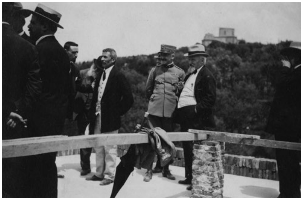
Fig. 13 – Cerimonia per la copertura del tetto dell'edificio di Fisica in Arcetri, 24 giugno 1916. Il Capitano Garbasso, al tempo Direttore del Servizio Fonotelemetrico dell'esercito, con il Sen. Torrigiani. [Archivio Storico Garbasso]
