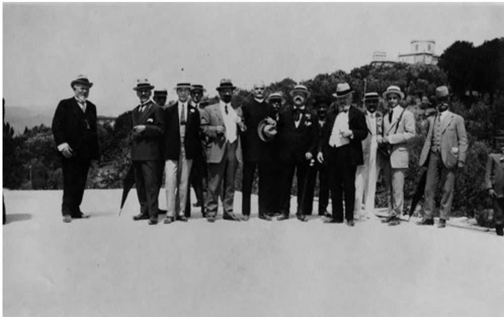
Fig. 15 – Cerimonia per la copertura del tetto dell'edificio di Fisica in Arcetri, 24 giugno 1916. Sullo sfondo si vede l'Osservatorio astronomico il cui Direttore, Antonio Abetti, è al centro della foto, senza cappello. [Archivio Storico Garbasso]
