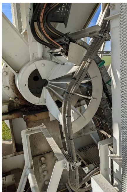
Figura 83 Snodo in elevazione dei tubi dell'elio a Medicina
