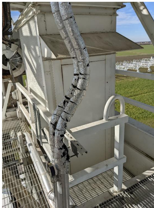
Figura 10 Linee acqua refrigerata allo snodo di elevazione a Medicina
