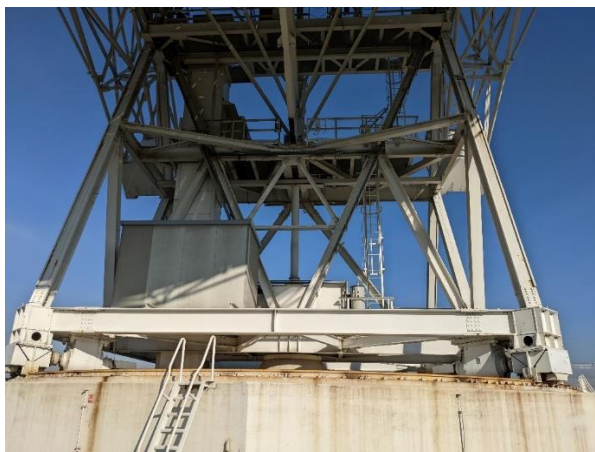
Figura 1 Posizionamento del fabbricato A.E.R. a Medicina (BO)
