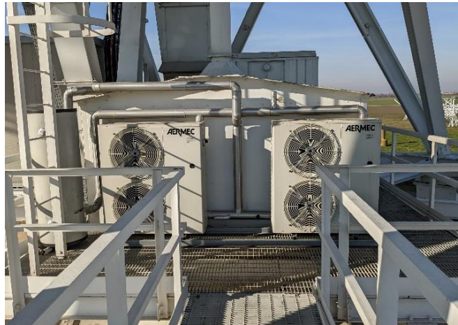
Figura 9 Macchine per refrigerazione acqua a Medicina
