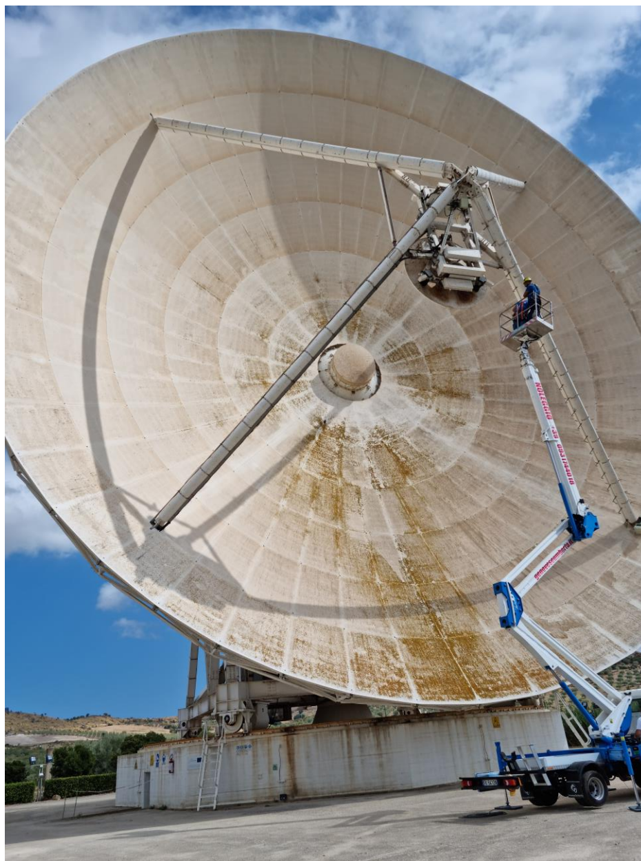
Figura 3-1 Antenna di Noto (SR) all'inizio dei lavori di sostituzione
