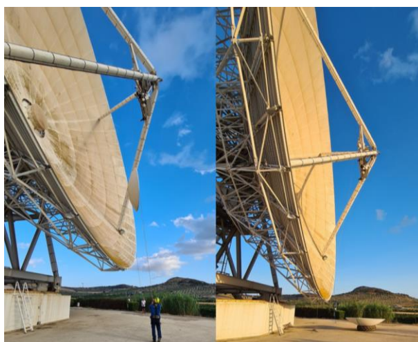
Figura 5-1 Smontaggio del subriflettore
