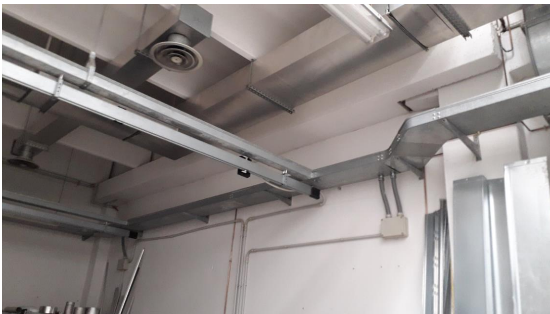
Figura 3 Stato attuale del soffitto che diventerà laboratorio. La parete al centro è quella in cui dovrebbe essere aperta la nuova porta di accesso al laboratorio.
