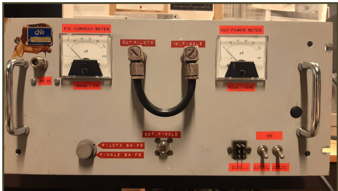
Stadio amplificatore di potenza dell'Oscillatore Locale 378 MHz – Rack 1
